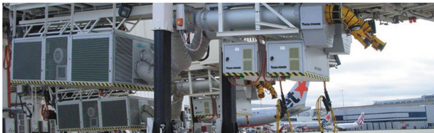
Аэродромный кондиционер PCA, аэродромный преобразователь и устройство подвода рукава, производства компании AXA Power, в аэропорту Мельбурна
